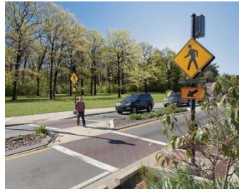
Traverse piétonne sécurisée
